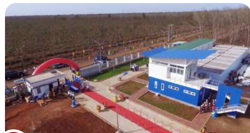
22 Nhà Máy Nước Chư Sê – Gia Lai
